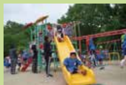
幼稚園総合遊具更新工事
