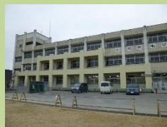
学校施設の耐震補強
