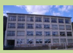
学校施設の耐震補強
