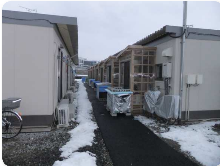
応急仮設住宅において飼養者と非飼養者で 居住区域を区分した例（福島県富田町） [写真提供：福島県獣医師会]
