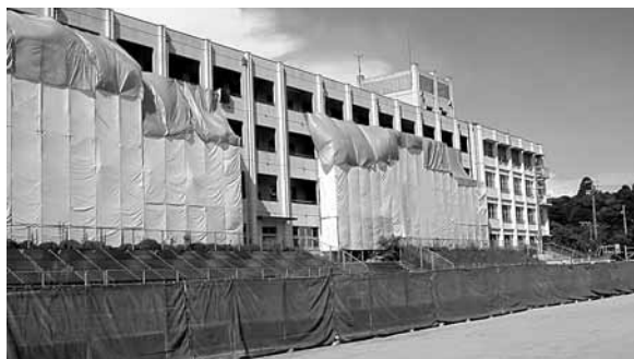
那波中学校 校舎耐震化工事
