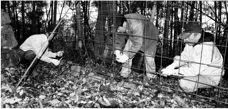
ワイヤーメッシュを1つずつ敷設（矢野町二木の山中）
