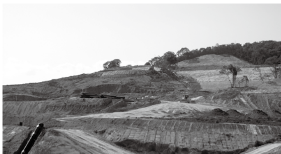
メガソーラー施設工事現場（椿ヶ丘）
