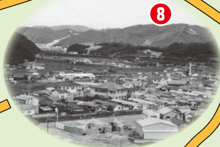
【昭和37年 東栄町住宅】
