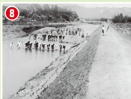
【昭和9年 大避神社前矢野川河川改修工事】
