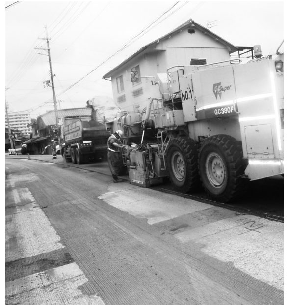
道路改修工事（那波本町）
