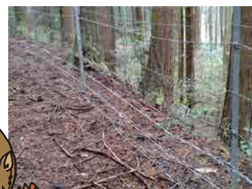
金網柵と下部の補強
