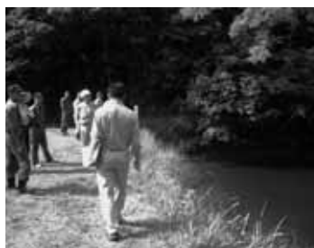
① ため池破損部など点検作業
