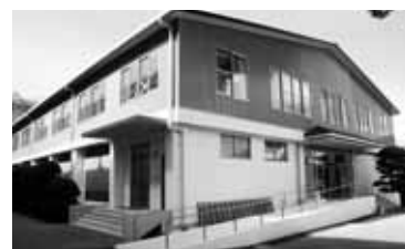
① 耐震改修を行った双中体育館
