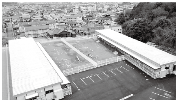
保育所仮設園舎 (相生保育所・矢野川保育所)
