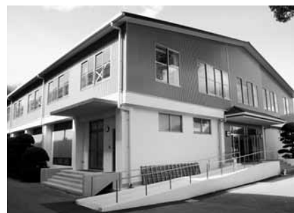
① 改装工事が完了した双葉中学校体育館
