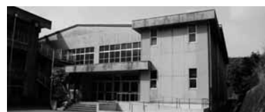
① 耐震補強を行った青小体育館
