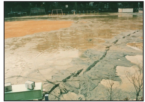
液状化による被害例 (写真提供：神戸市)
