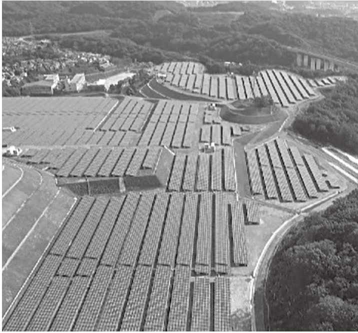
太陽光発電施設（椿ヶ丘）
