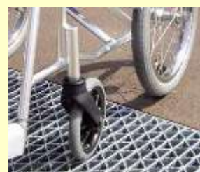
タイヤなどが落ち込みにくい側溝のふた
