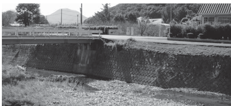
河川管理用通路（愛老園・椿の園進入路付近）
