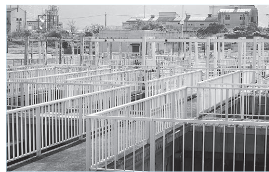
下水道管理センター
