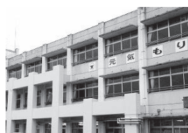
耐震補強事業
