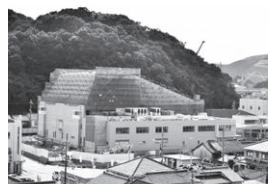
文化会館建設工事
