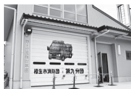
第9分団車庫移設工事
