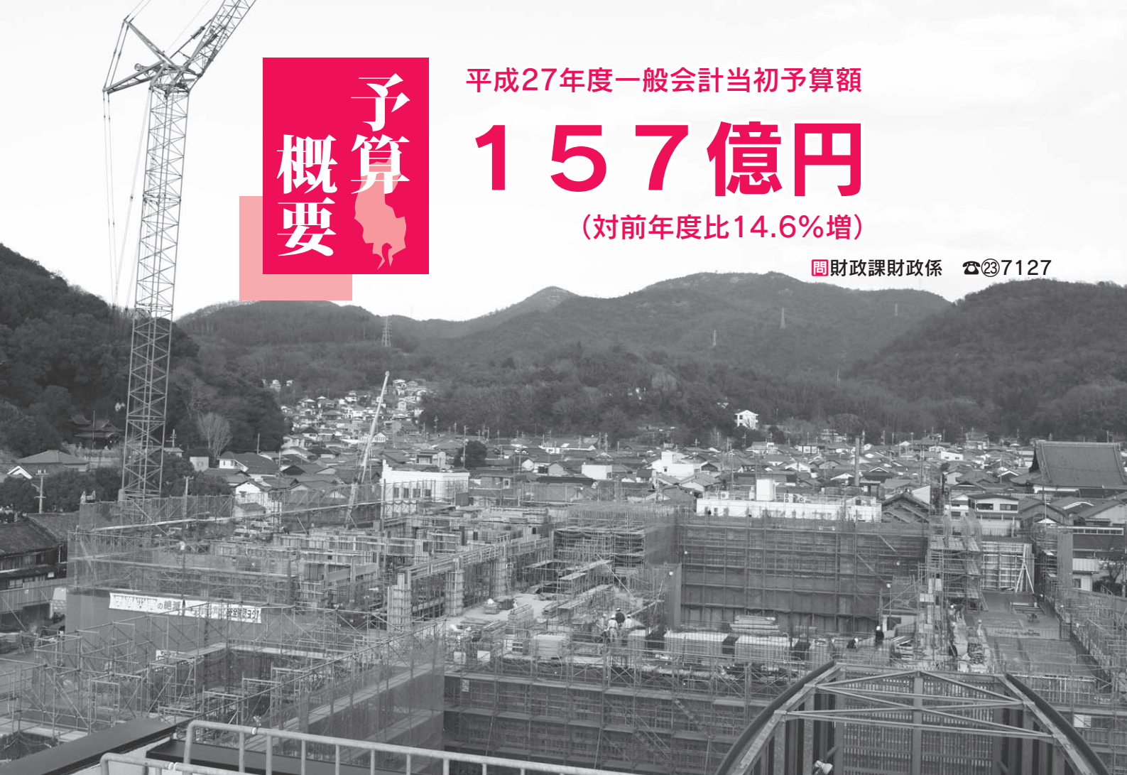
建設中の「仮称・相生市文化会館」(2月末現在)
