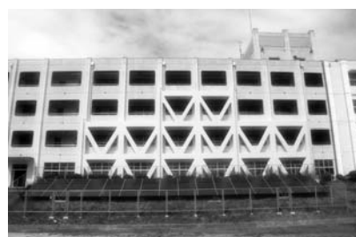
耐震補強工事（那波中学校）
