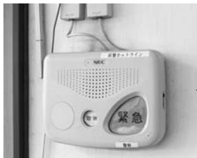
防犯アイテムその② ■県警ホットライン 警察へ直接つながっている専用回線。迅速な連絡、対応が可能となる。
