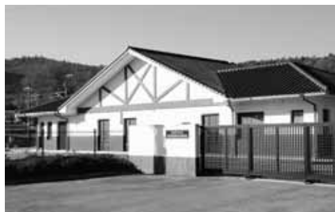
農業集落排水処理施設
