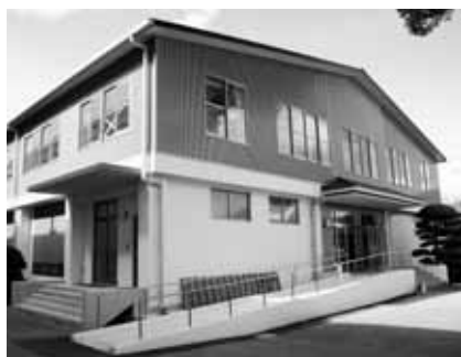
① 改修工事が完了した双葉中学校体育館
