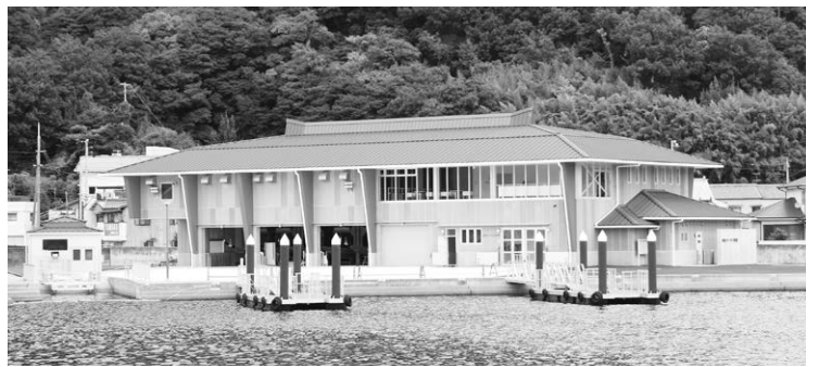
完成した相生ペーロン海館
