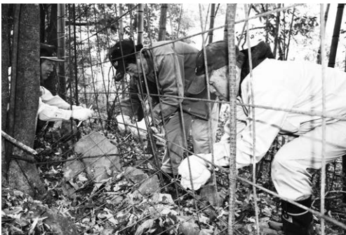
ワイヤーメッシュの敷設の様子
